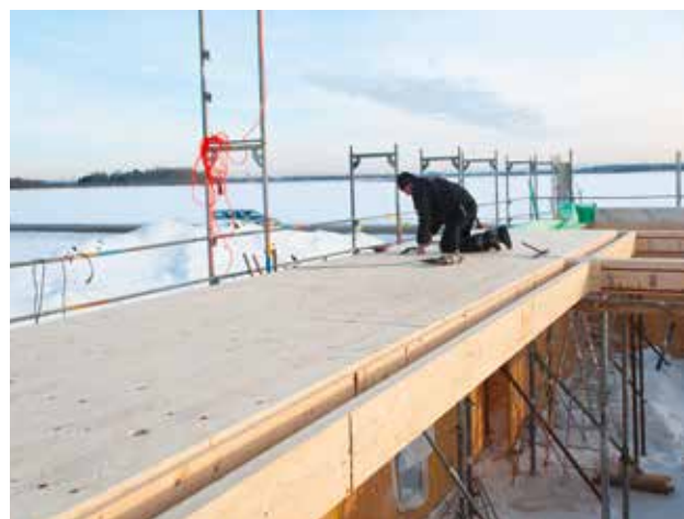
Utilisation de STEICO LVL X pour renforcer la dalle de plancher.
