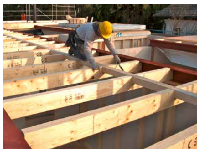
Construction de structure porteuse de plancher avec STEICO LVL R.
